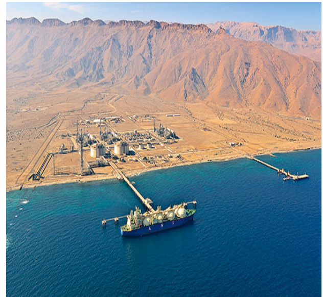
Figure 6: Qalhat LNG Export Terminal
